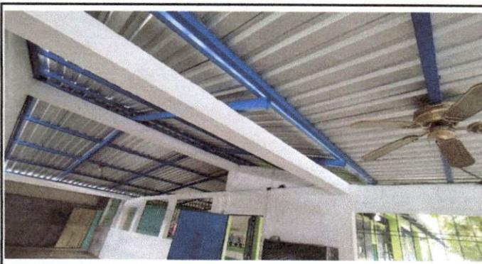
Foto 4: Panorámica de interior de aula con estructura de soporte y lámina aluzinc terminado
